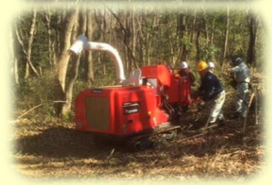
⑤ ~作業中~ 平成28年1月19日撮影
