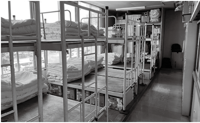
改修予定の消防署仮眠室
