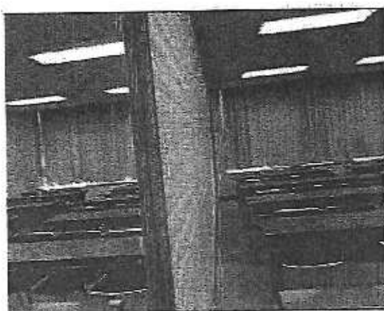
部屋を仕切っているパーティション。(赤線の表示) 防音仕様ではなく、吊り下げ方式のため、隣室士の「音」が漏れ聞こえる状態。
