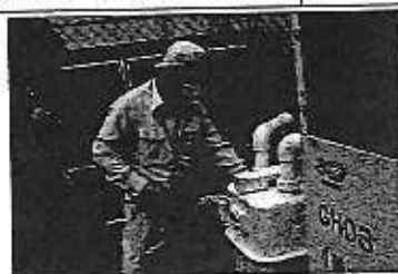
ガスメーターの交換
