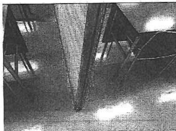
部屋を仕切っているパーティション。(赤線の表示) 防音仕様ではなく、吊り下げ方式のため、隣室士の「音」が漏れ聞こえる状態。
