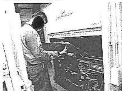
空調機保守点検
