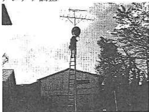
写真① アンテナ調整
