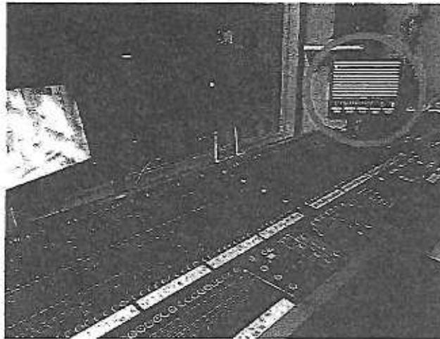
調光操作卓のモニターで負荷異常を検出し、画面に異常情報の表示がでない
