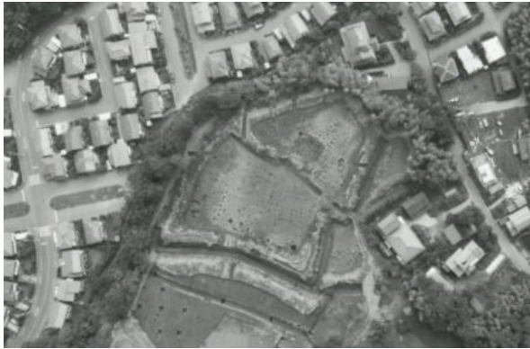
和良比堀込城跡航空写真
