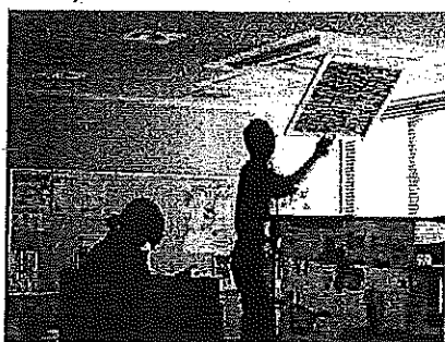
空調機保守点検
