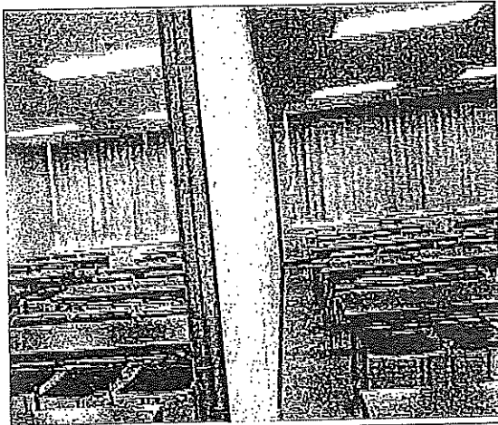
部屋を仕切っているパーティション。(赤線の表示) 防音仕様ではなく、吊り下げ方式のため、隣同士の「音」が漏れ聞こえる状態。
