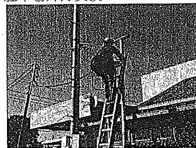
写真⑥ 駐車場外灯交換
