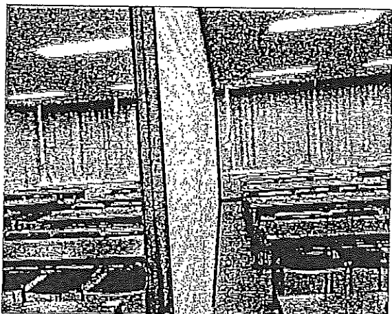
部屋を仕切っているパーティション。(赤線の表示) 防音仕様ではなく、吊り下げ方式のため、隣同士の「音」が漏れ聞こえる状態。
