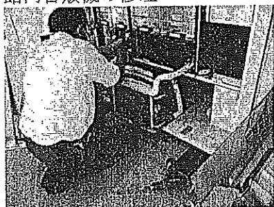
写真① 館内自販機の修理
