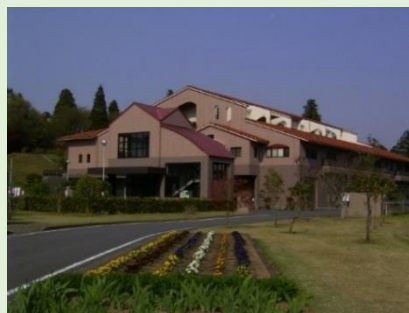
印旛衛生施設管理組合 汚泥再生処理センター
