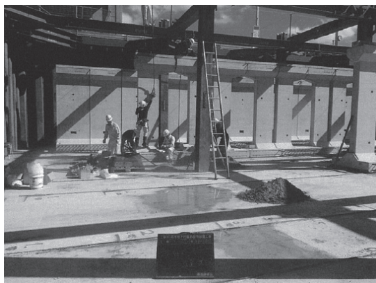
雨水貯留施設工事
