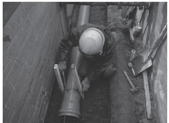
下水道管改築工事
