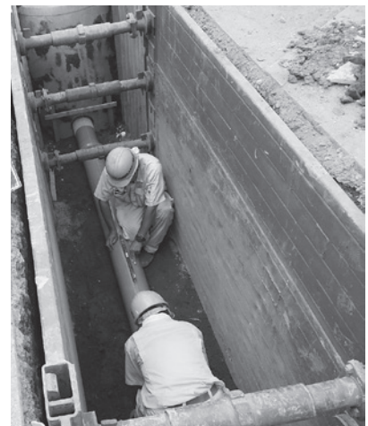
下水道整備工事
